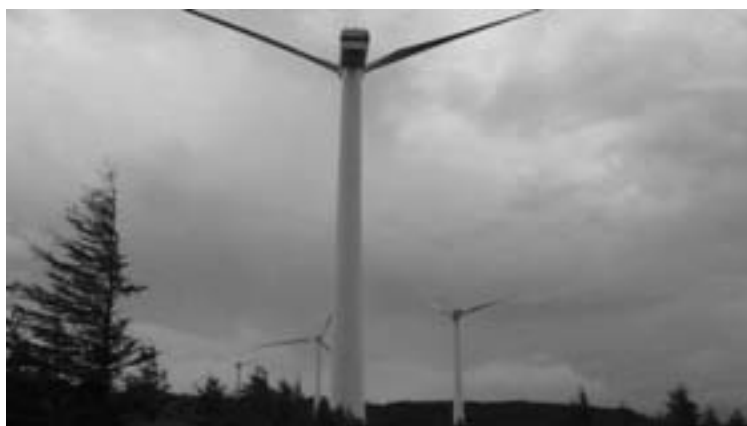
図表 16 葛巻町の風力発電所
