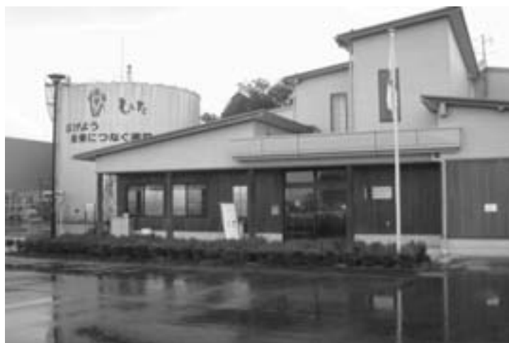
図表 17 日田市バイオマス資源化センター
