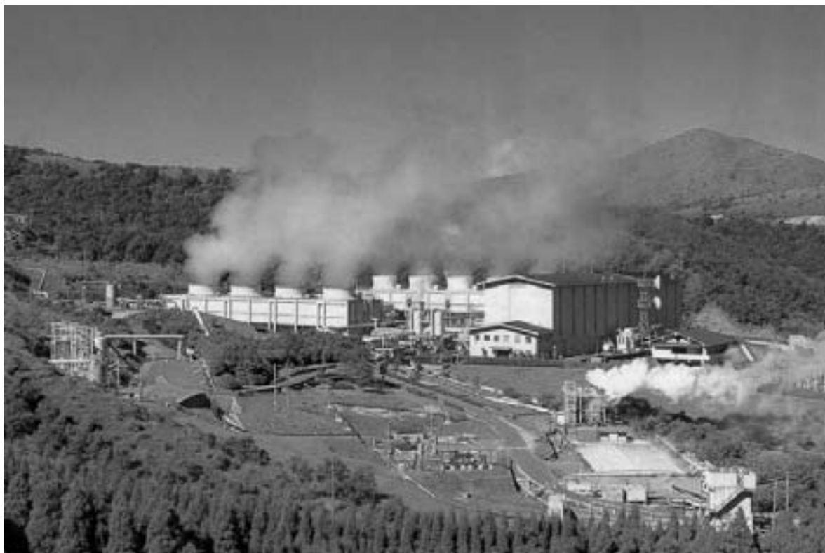
写真：九州電力（株）八丁原地熱発電所
